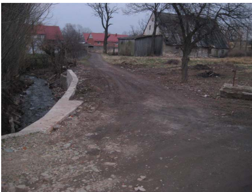
Fotografia 3 – Odcinek drogi gruntowej miejscami zbudowanej z tłucznia
